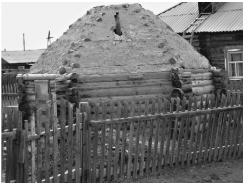
Многоугольная бревенчатая постройка алтайцев — жилище переходного типа от юрты к срубному
